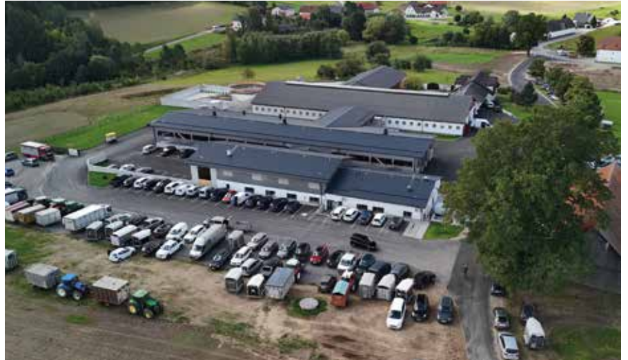
Neue Vermarktungsanlage in Rottenbach
